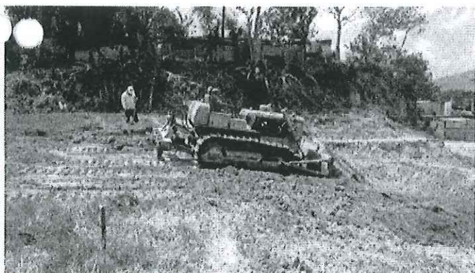
Fotos, 1,2, Tractor de banda realizando reacomodo y distribución de material
