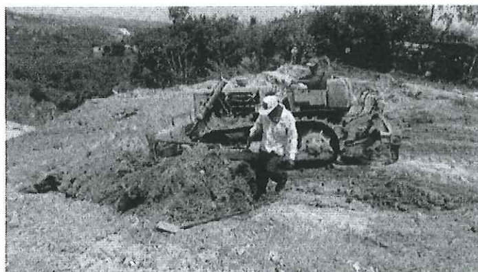
Fotos, 1,2, Tractor de banda realizando reacomodo y distribución de material
