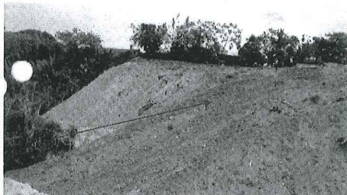
Foto, 3, Formación de taludes no conformados y material suelto
